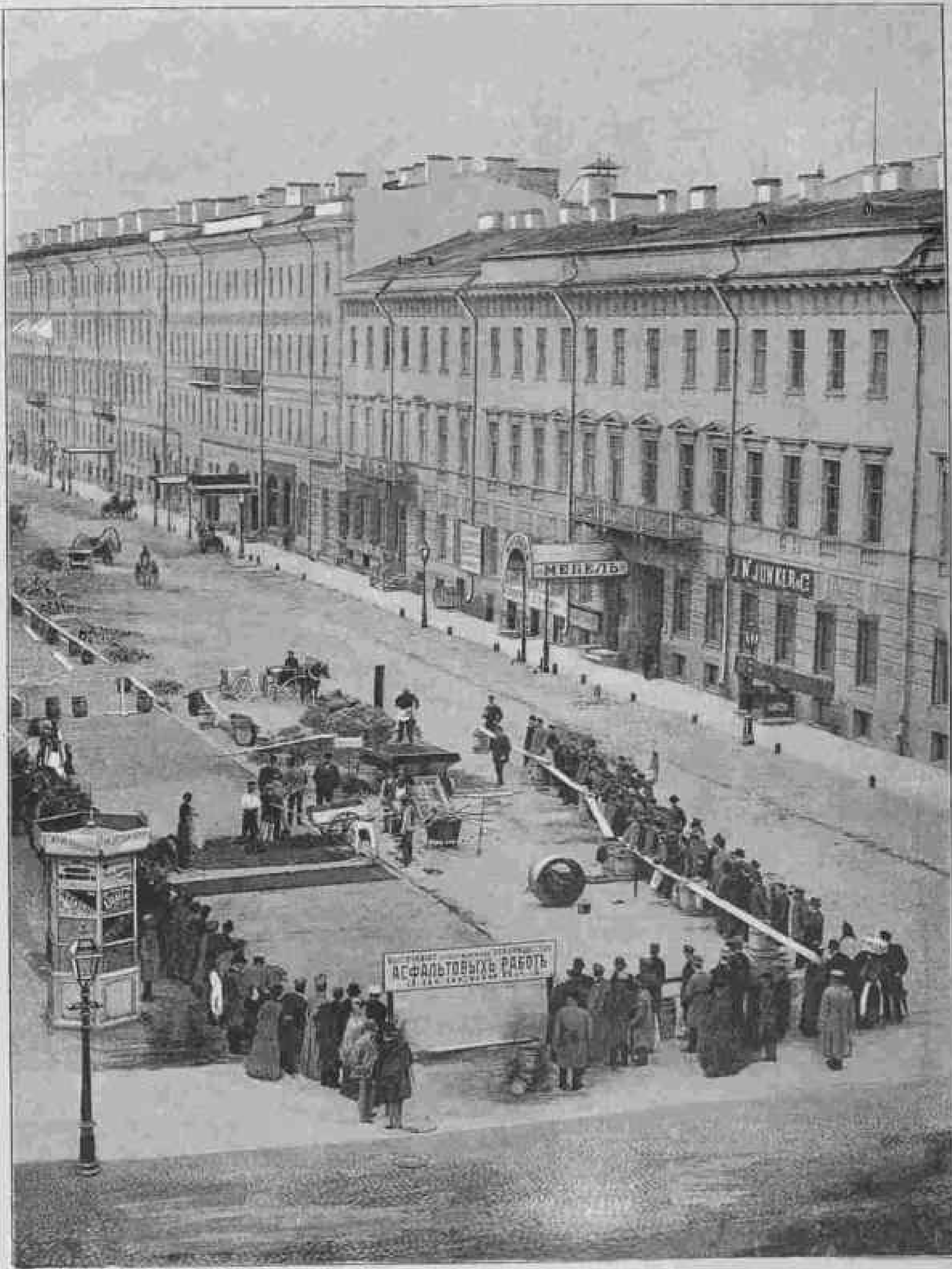
С.-Петербургъ. — Работы по устройству асфальтовой мостовой на Большой Конюшенной улицѣ по новому способу.
